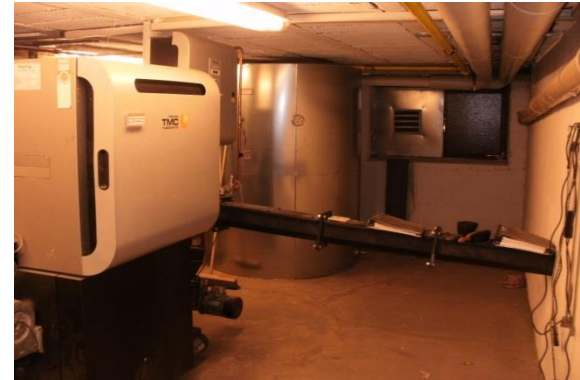
Holzhackschnitzelheizung Kita Alsenborn
