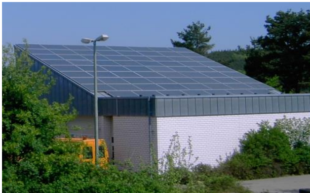
Bauhof E.-A. (20 kW)
